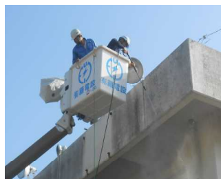
②高圧洗浄機で壁をきれいに
